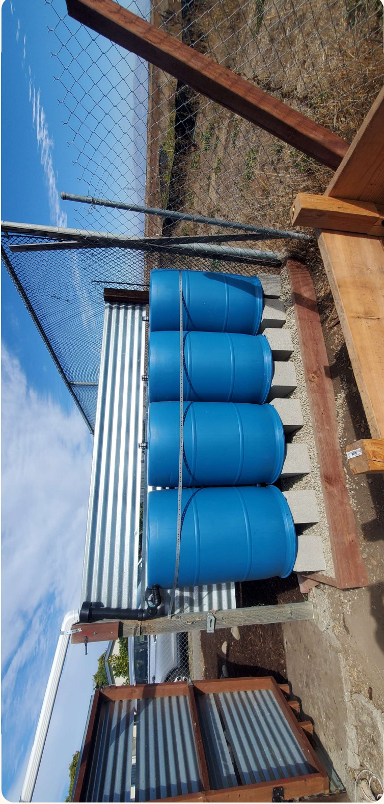
Installed rain barrels Barriles de lluvia instalados
